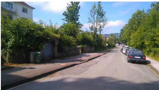
Das steile Gelände muss durch Mauern abgefangen werden. Die Gärten sind hier unterschiedlich gestaltet. Neben standortgerechten Laubgehölzen sind auch viele Ziergehölze vorhanden.
