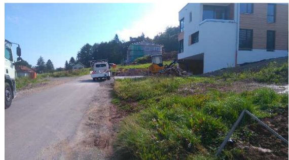
Im Bereich der Grünlandflächen wird derzeit schon gebaut.
